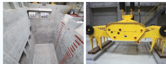
ごみピット・ごみクレーン Waste pit and waste crane
